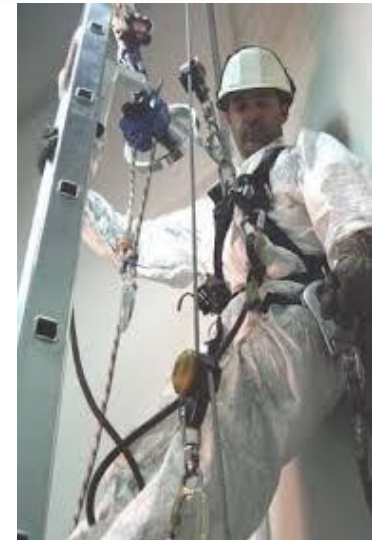
Figura 1. Operario equipado con arnés, absorbedor de energía con doble elemento de amarre, dispositivo anticaída deslizante para línea de anclaje rígida, casco de seguridad, botas de seguridad, linterna frontal para zonas de baja iluminación.
